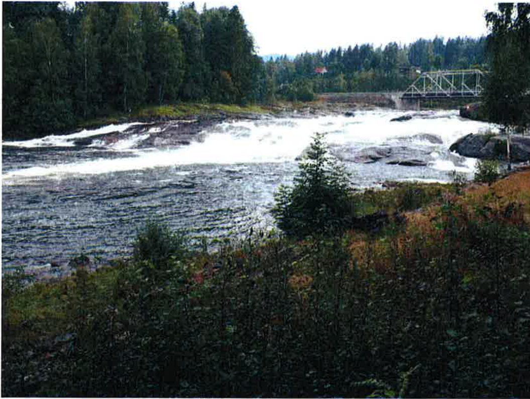
Figur 6.4. Omnesfossen ved noe over middels vannføring, 28,43 m 3 /s, 20.08.07. (Foto: Skagerak Kraft AS.)
