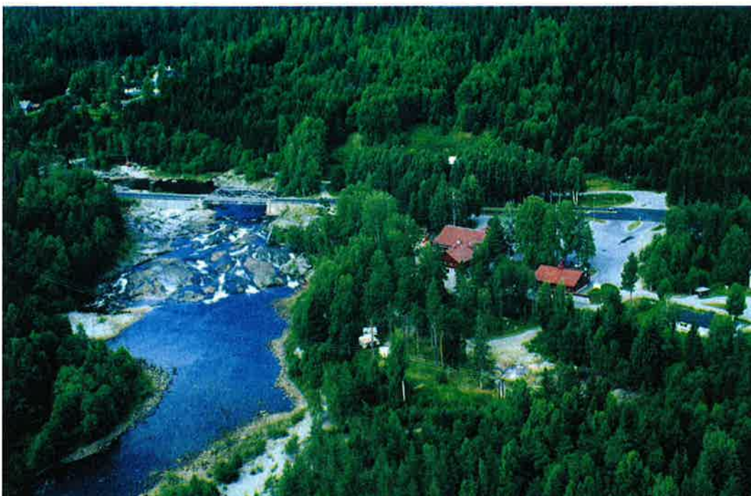
Figur 5.3. Omnesfossen, Fossen Kro & Motell til høyre. E134 krysser elva over brua. (Foto: Skagerak Kraft).
